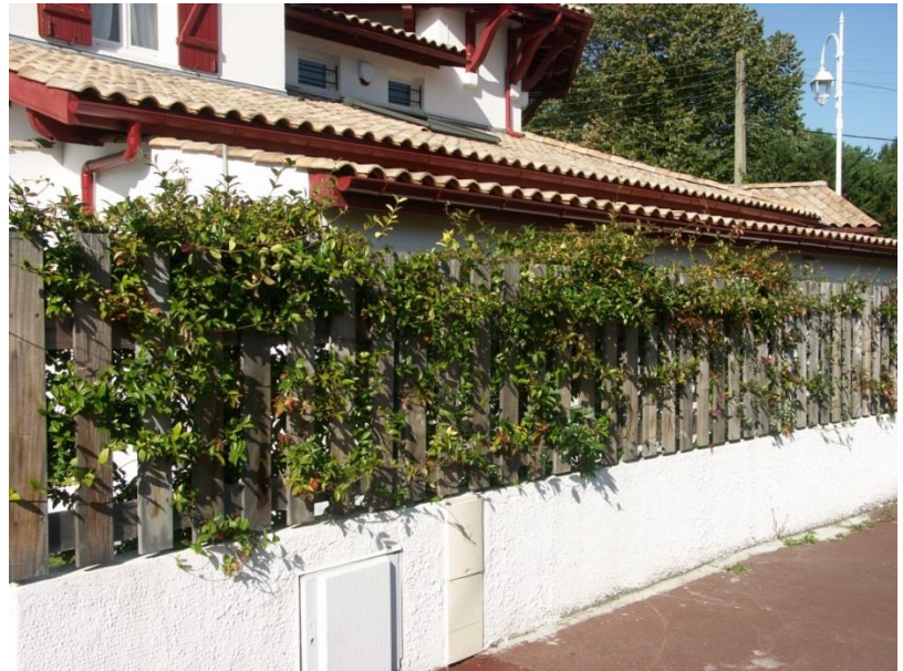
La clôture av. du Maréchal Lyautey après modification
